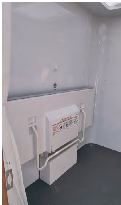
W mobile toilet znajduje się składana leżanka naścienna, o długości 160 cm. Służy do zmiany pieluch i ubrań oraz do odkładania rzeczy osobistych. Jest też stały uchwyt, którego długość, położenie i kąt umocowania ułatwiają chwytanie.
