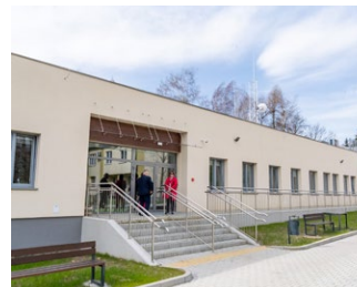
Centrum Opiekuńczo-Mieszkalne, Rzeszów
