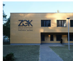
Budynek administracyjno-biurowy dla Zakładu Gospodarki Komunalnej, Konstancin-Jeziorna
