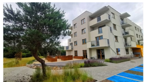
Budynek wielorodzinny przy ul. Dickmana 30
