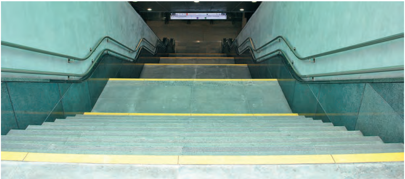
Warszawa: zejście na stację metra Stadion Narodowy. Zapewniono kontrastowe oznaczenia pierwszego i ostatniego stopnia każdego biegu schodów.
